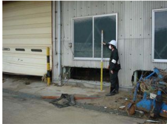
写真 2.2.5-28 堤防脇における浸水深測定
