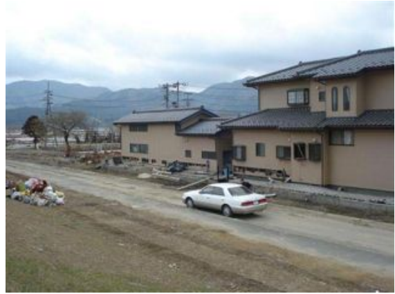
写真 2.2.3-15 越水による家屋の破壊
