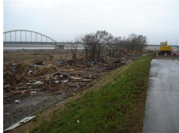
写真 2.2.2-5 左岸堤防上から堤外上流側を望む
