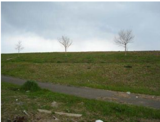
写真 2.2.5-29 堤内側の法面
