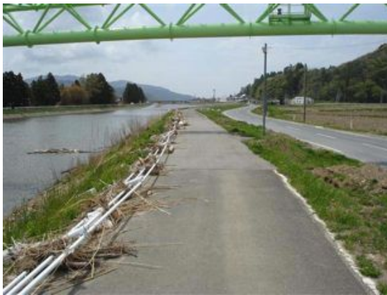
写真 2.2.3-7 堤内側に倒伏するフェンス
