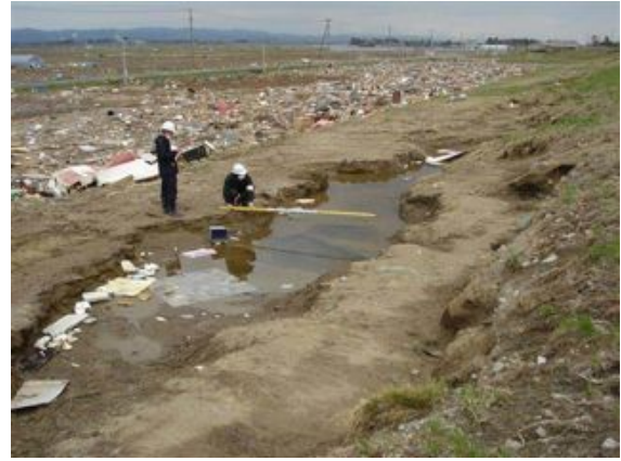
写真 2.2.5-26 堤内地法尻における落堀
