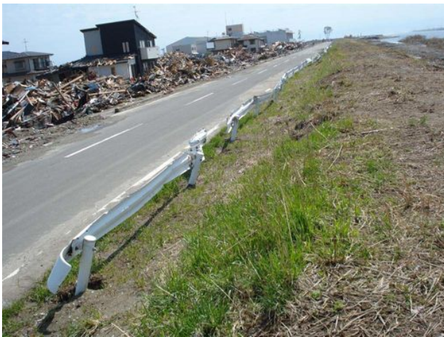
写真 2.2.1-15 堤外側に倒伏するガードレール 写真 2.2.1-16 堤外の法尻部における落堀
