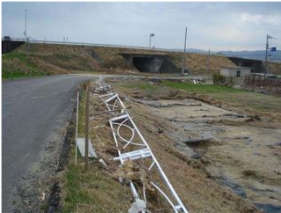
写真 2.2.5-25 フェンスの変形
