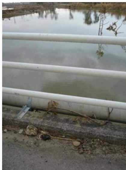
写真 2.2.5-6 新浜水門管理通路
