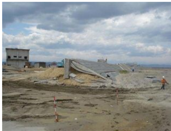
写真 2.2.5-4 海岸堤防の破壊状況
