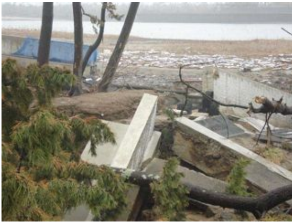
写真 2.2.1-3 河口部の破堤
