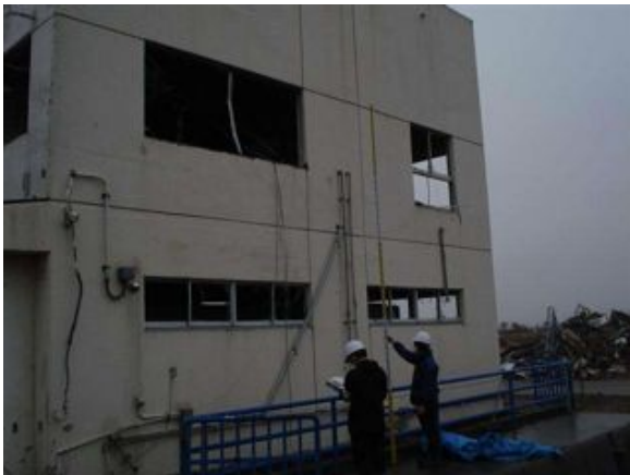
写真 2.2.1-5 蒲生排水機場
