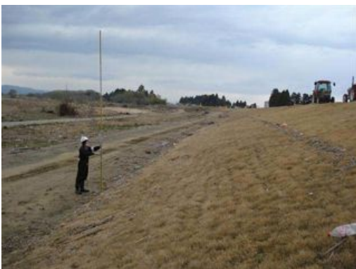
写真 2.2.5-30 堤外法面に残る遡上痕跡
