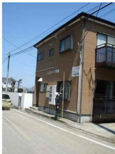
写真 2.2.4-2 浸水痕跡高さ（浸水深）の測定
