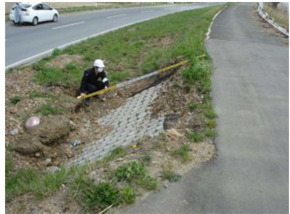
写真 2.2.3-8 川裏側法面の洗掘
