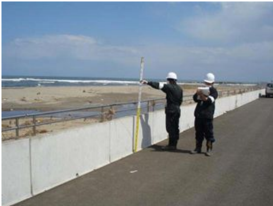
写真 2.2.5-7 堤頂のフェンスに付着する漂流物
