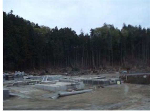
写真 2.2.3-6 家屋の流失（基礎のみ残る）
