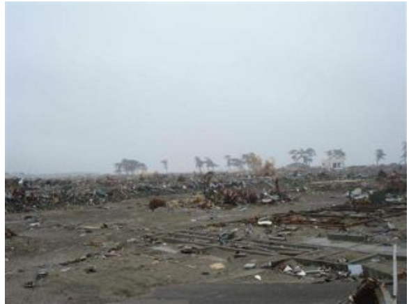
写真 2.2.1-10 家屋の流失状況
