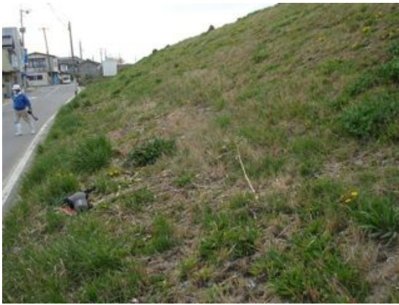
写真 2.2.5-11 堤内側法面における洗掘
