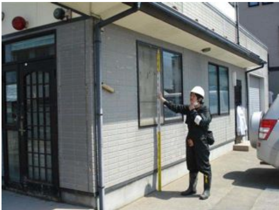
写真 2.2.4-8 浸水痕跡高さ（浸水深）の測定
