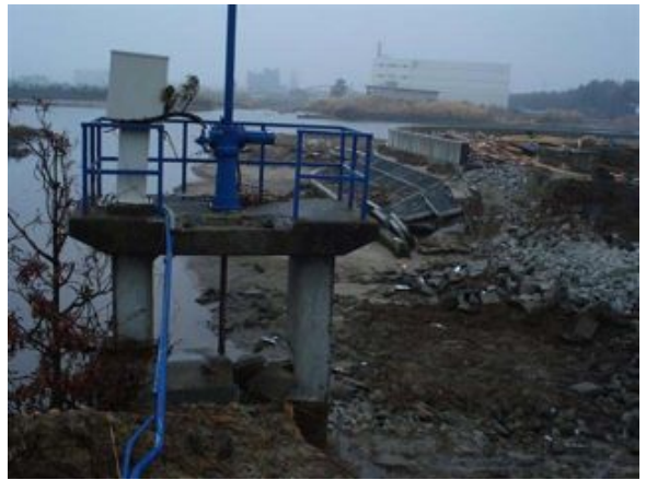
写真 2.2.1-4 蒲生排水機場の排水路河口部
