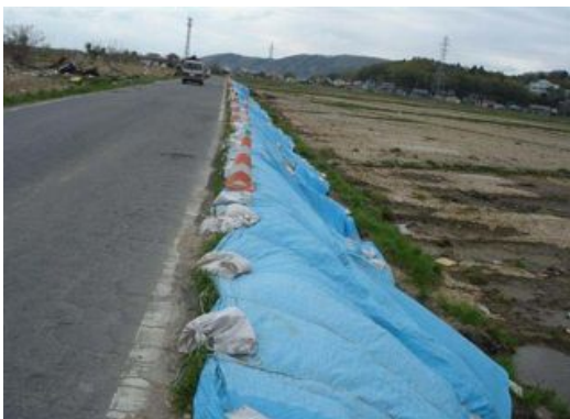
写真 2.2.4-11 川裏側法面における洗堀跡
