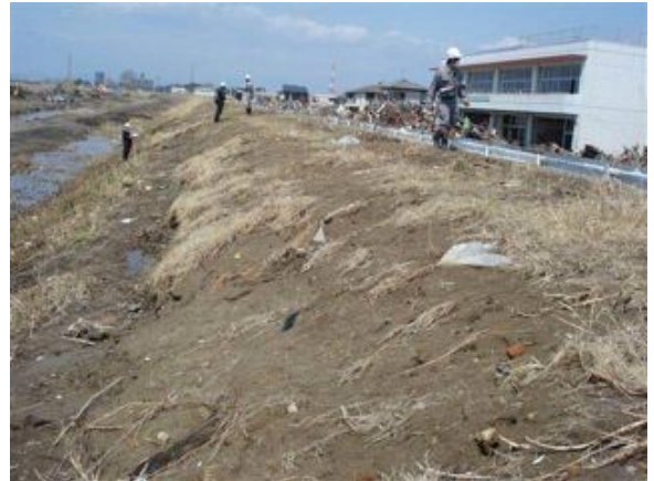
写真 2.2.1-13 小学校背後における残存家屋 写真 2.2.1-14 堤内地から河川への越流跡
