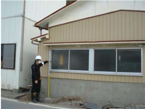
写真 2.2.4-10 浸水痕跡（浸水深）の測定
