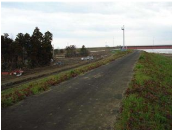
写真 2.2.5-21 亘理大橋より上流側(堤防)
