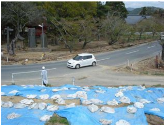
写真 2.2.3-16 堤内法面における洗掘跡
