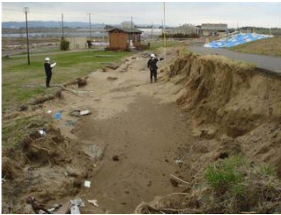
写真 2.2.5-27 堤内地の法面における落堀
