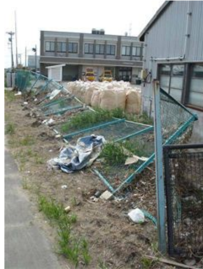
写真 2.2.4-15 運河からの氾濫により倒伏したフェンス
