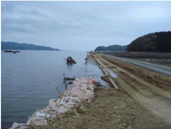
写真 2.2.3-5 河口部周辺の被災状況
