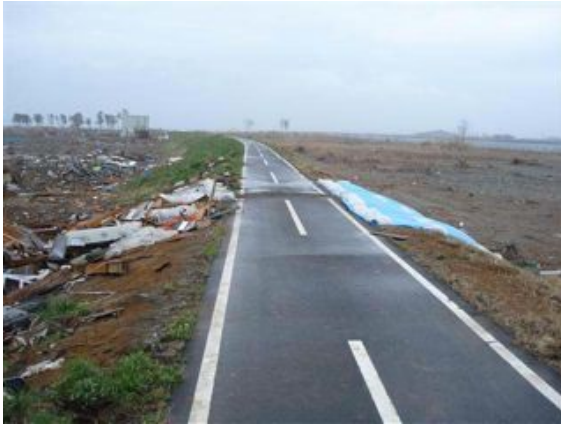
写真 2.2.2-2 左岸堤防の損傷
