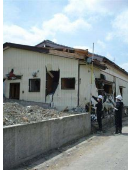
写真 2.2.3-4 周辺の浸水痕跡高さの測定
