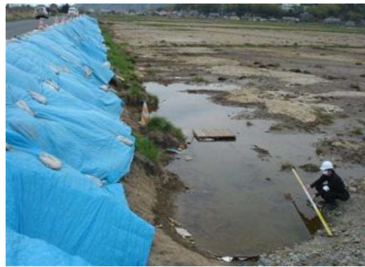
写真 2.2.4-12 川裏側法尻部に生じた落堀
