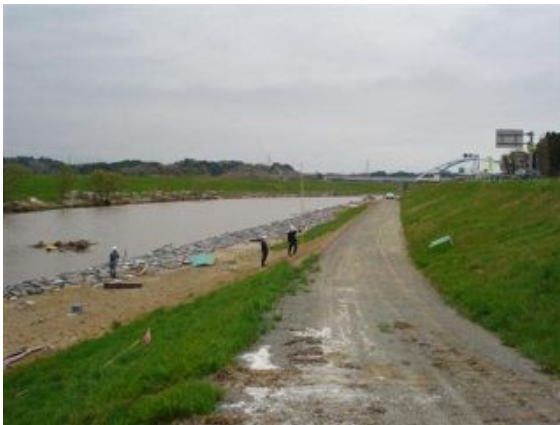
写真 2.2.6-4 河道内に残る痕跡の測定
