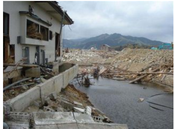
写真 2.2.3-10 家屋の破壊状況
