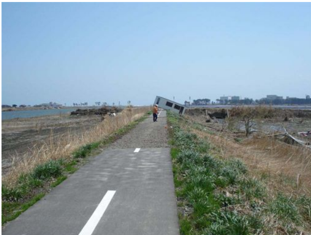
写真 2.2.1-17 天端に乗り上げたプレハブハウス 写真 2.2.1-18 堤内へ漂流した河道樹林
