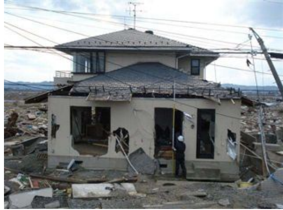
写真 2.2.5-16 堤防脇における家屋の破壊状況
