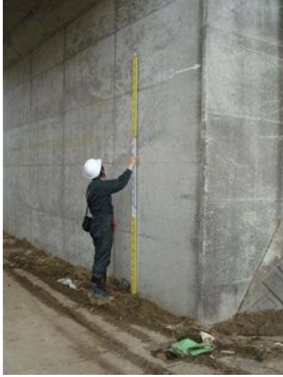
写真 2.2.5-23 国道 10 号線カルバート通路
