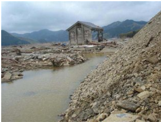
写真 2.2.3-9 堤内側法尻における落掘
