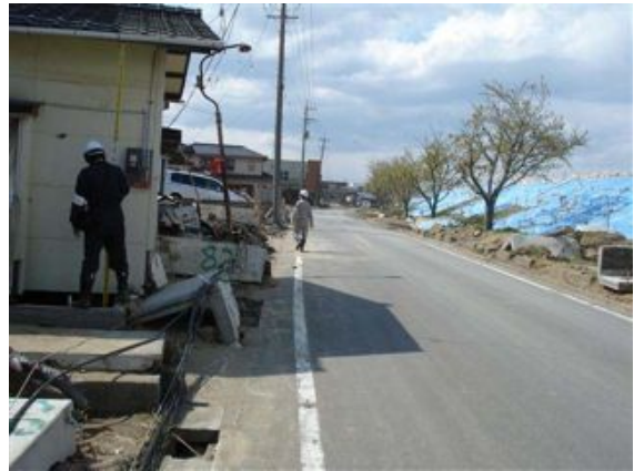
写真 2.2.5-10 堤防脇の家屋における 浸水深測定
