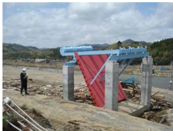
写真 2.2.3-2 流失したゲート
