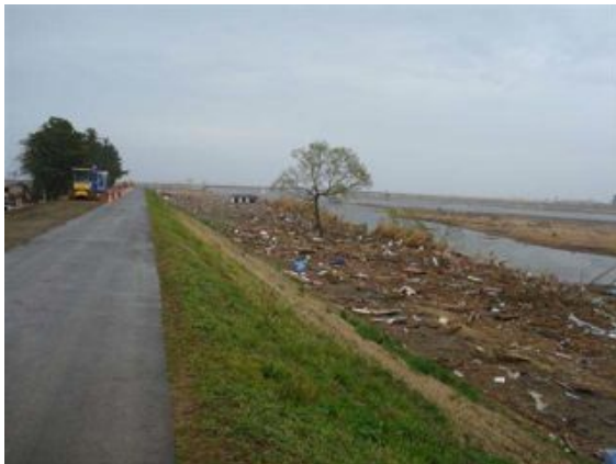
写真 2.2.2-4 左岸堤防から堤外下流側を望む
