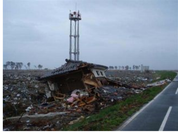
写真 2.2.2-3 閑上大橋へのアプローチ道路 (阻害線：堆積した漂流物)
