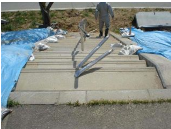
写真 2.2.5-9 堤内方向に変形する手すり
