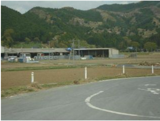
写真 2.2.3-18 8.6km 上流部の天端状況
