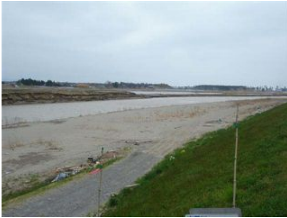
写真 2.2.6-2 下流側にアプローチ道路を望む
