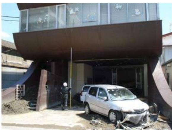
写真 2.2.4-5 浸水痕跡高さ（浸水深）の測定
