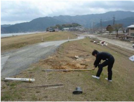
写真 2.2.3-14 天端付近の越水痕
