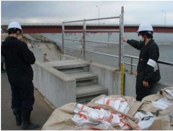
写真 2.2.5-18 天端フェンスに付着する漂流物
