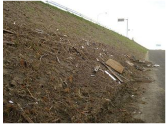
写真 2.2.5-24 国道 10 号線の盛土に残る 浸水痕跡
