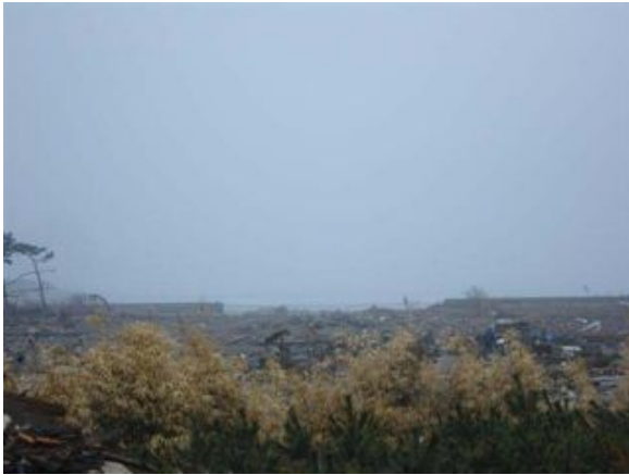
写真 2.2.1-1 海岸堤防の破堤
