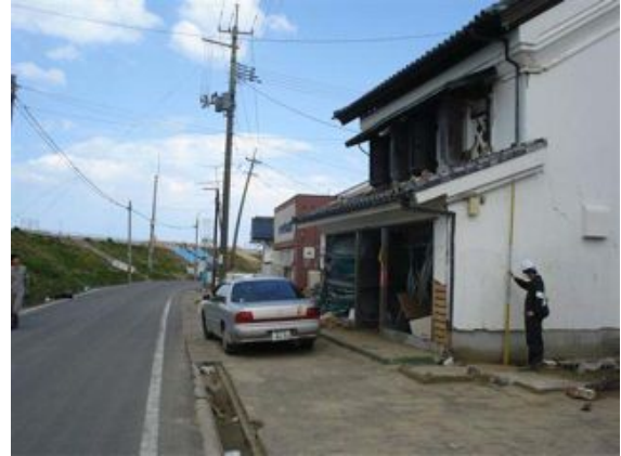
写真 2.2.5-12 堤防脇の家屋における 浸水深測定
