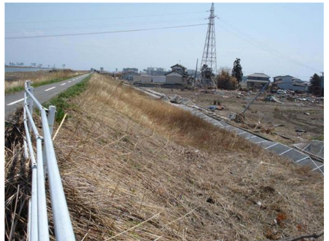
写真 2.2.1-20 堤内側へ倒伏したフェンス
