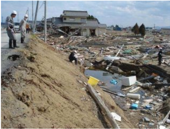
写真 2.2.5-17 堤内地法尻にできた落堀
