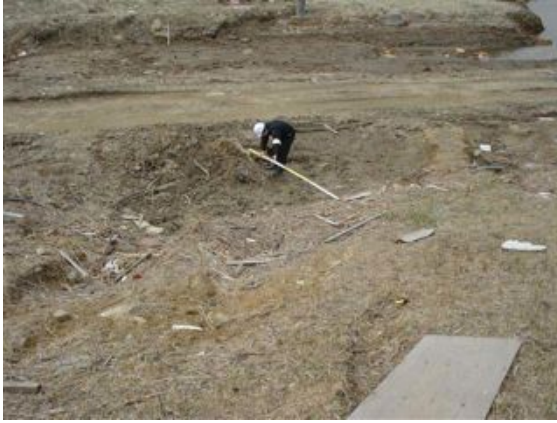
写真 2.2.3-11 堤内法尻部の洗掘
