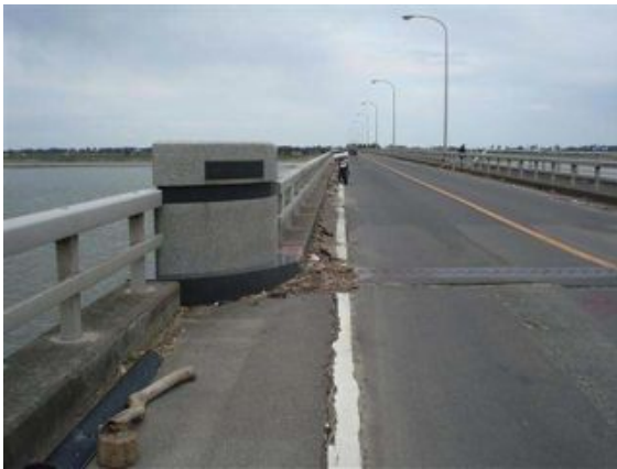
写真 2.2.5-20 亘理大橋(右岸側から望む)
