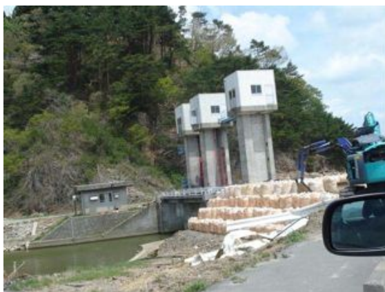
写真 2.2.3-1 月浜第二水門
