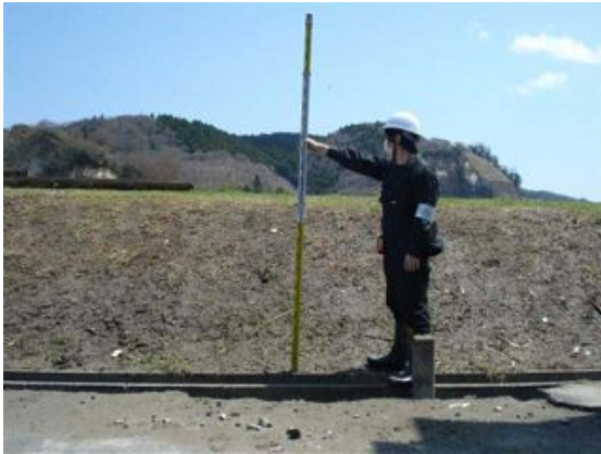
写真 2.2.4-6 堤防にのこる越流跡
