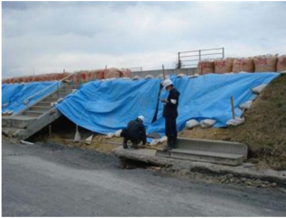
写真 2.2.5-15 堤内側法面における洗掘状況
