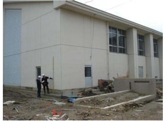
写真 2.2.3-12 堤防付近の浸水深測定
