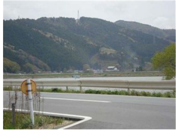
写真 2.2.3-19 9.4km 上流部の天端状況
