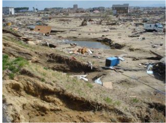
写真 2.2.5-8 堤内側法面の洗掘
