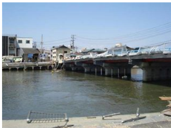
写真 2.2.4-4 遡上津波の直撃を受けた橋脚
