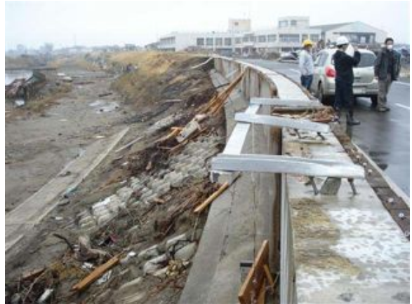
写真 2.2.1-8 堤外側に倒伏するフェンス
