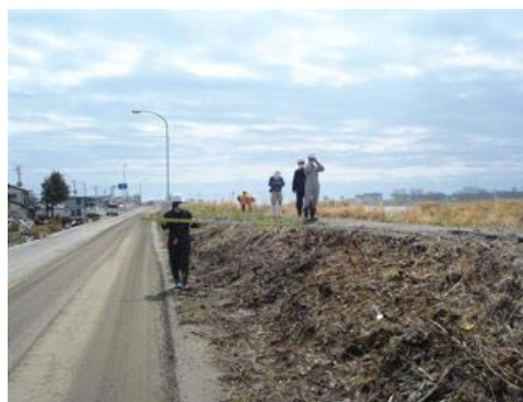
写真 2.2.1-22 河川側からの越流痕
