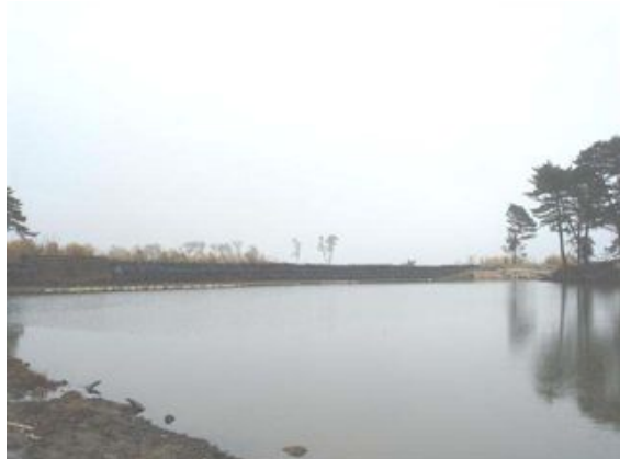
写真 2.2.1-6 右岸河口部における破堤箇所
