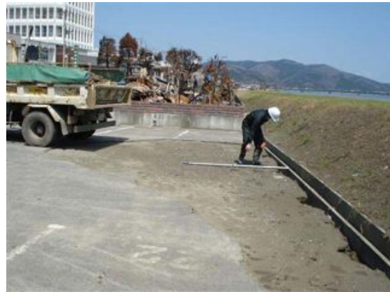
写真 2.2.4-7 越流により出来たアスファルトのはがれ
